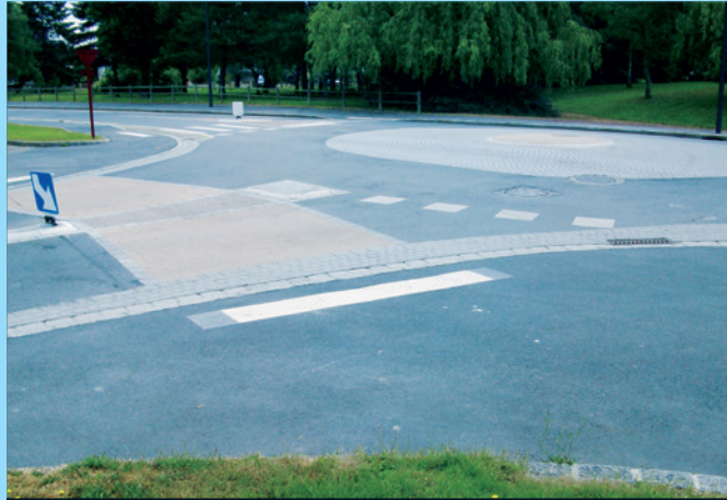
Verkehrsteiler hier am Beispiel «Kreisverkehr»
