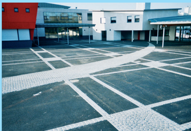
Areale bei öffentlichen Gebäuden
