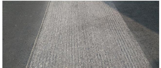
Préparation des surfaces afin de maintenir le dévers de la chaussée et créer un raccord net et durable entre le bitume et le revêtement coloré
