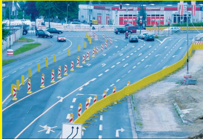
Stau- und Unfallminimierung mit B.A.S. Verkehrssicherung
